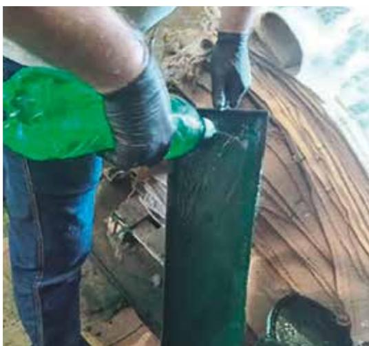
Lavagem do reservatório de tinta e transferência do resíduo para as bombas
