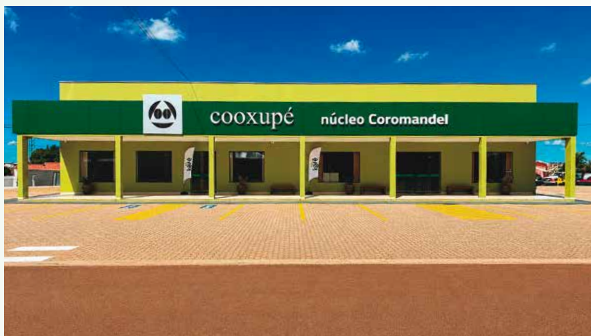
Cooperados de Coromandel ganham nova estrutura do núcleo
